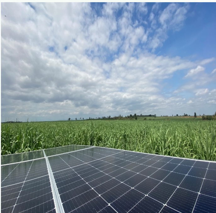
Lắp hệ thống năng lượng mặt trời
